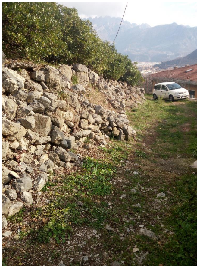
Figura 9 - Muro esistente in cattive condizioni con parti crollate
