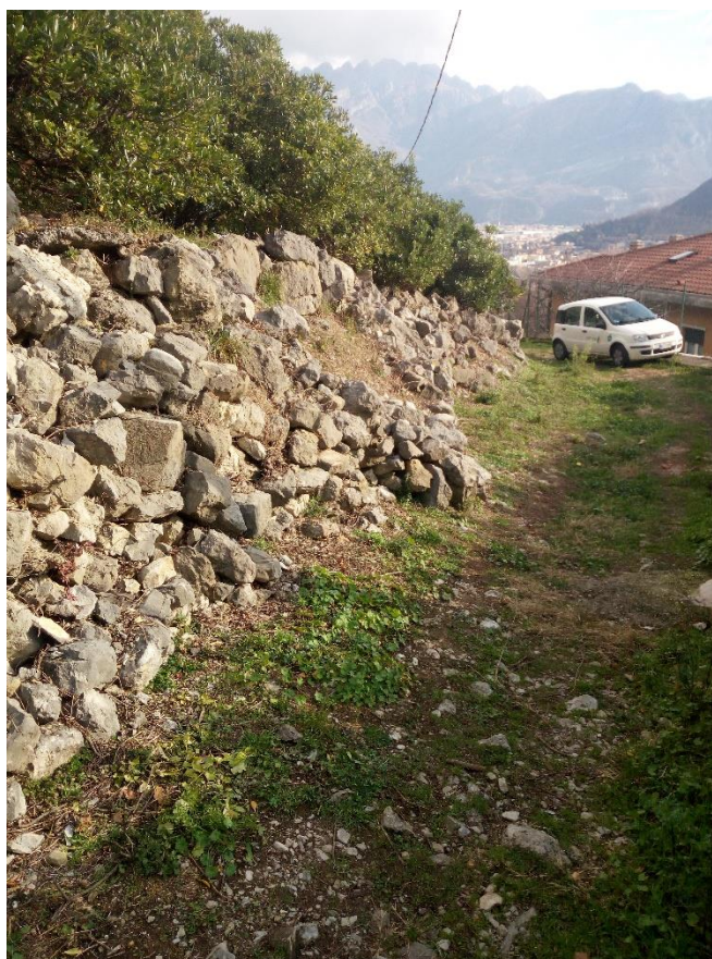
Figura 5 - Muro esistente in cattive condizioni con parti crollate
