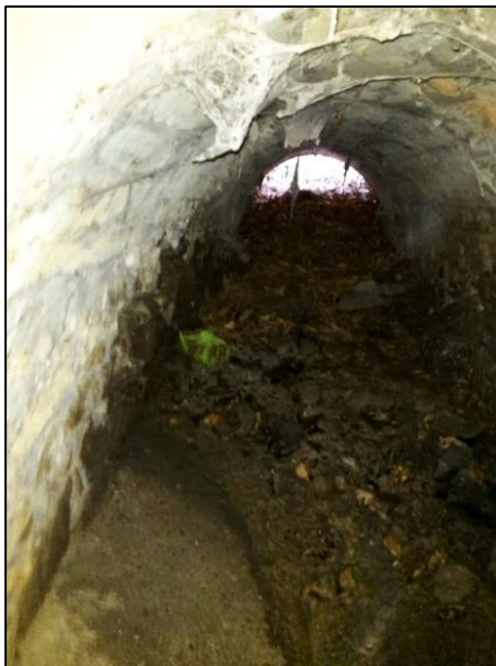
Figura 10: Scarico acque di tipo misto – Frazione Narro
